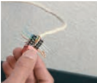
2. Determine wiring scheme. Dress all 4 pairs (8 wires).
